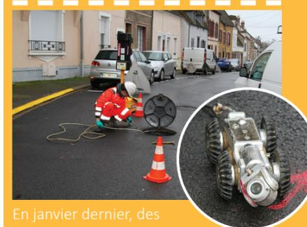
En janvier dernier, des travaux de chemisage ont été effectués rue Georges Fessard. Cette opération "chirurgicale" visait, à l'aide d'un mini-robot doté d'une caméra, à inspecter dans un premier temps les canalisations et déceler les potentielles usures. Suite à cela un curage par envoi d'eau à haute pression a été effectué. Pour terminer, un chemisage des canalisations a été effectué.
