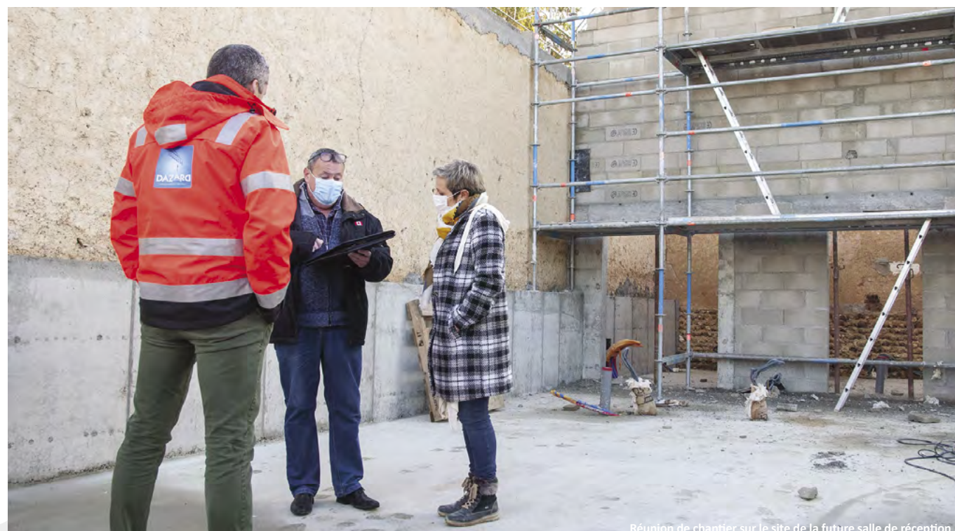
Réunion de chantier sur le site de la future salle de réception
